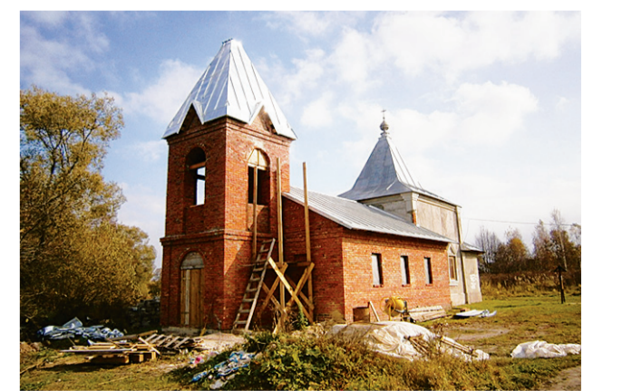
Строительство колокольни. 2013 г.
