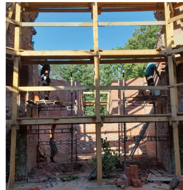
Строительство алтарной части храма.
